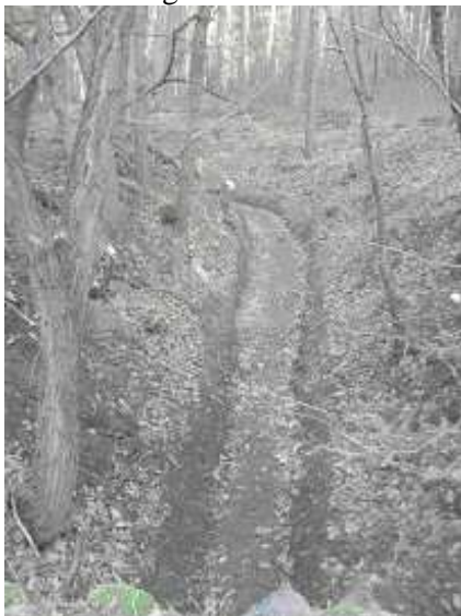
Instandgesetzter Abschnitt des Rotenmühlgrabens
